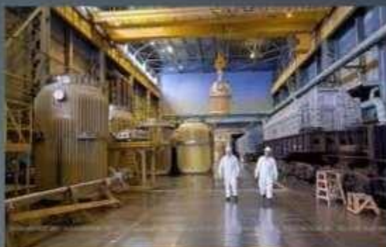
предприятия по переработке или изготовлению ядерного топлива
